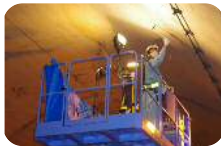
～トンネル点検の様子～
