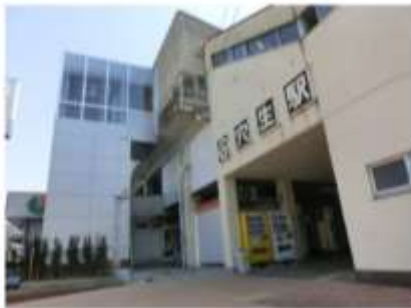
■エレベーターの設置（筑鉄穴生駅）
