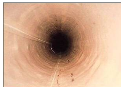
修繕後：管更生
