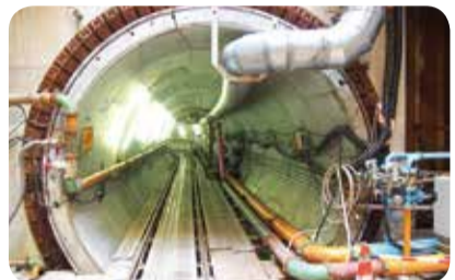
B 雨水貯留管
