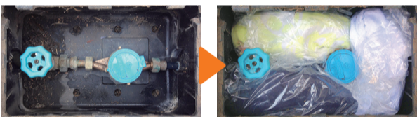
水道メーターの保温
