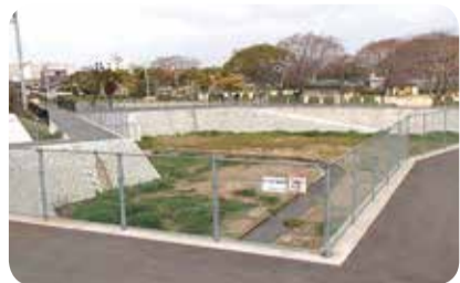
A 雨水調整池
