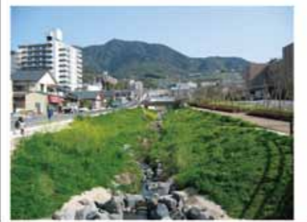
整備後の写真
