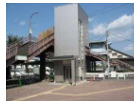
九州工大前駅のエレベーターの設置
