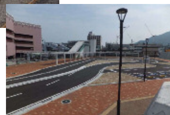
図 城野駅南口駅前広場の整備
