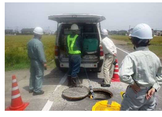
○ 二次調査（TVカメラによる詳細調査）
