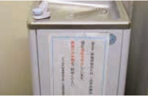
冷水機等不要設備の停止
