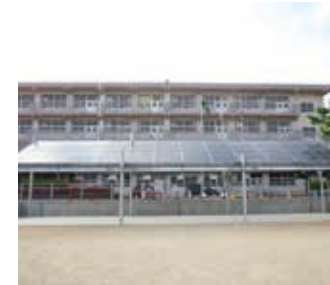
太陽光発電設備（出力10kWの設置例）
