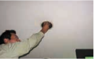
白熱電球の LED 照明への更新
