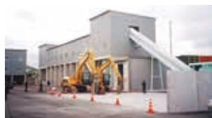
建設混合廃棄物リサイクル事業 建築物の解体現場などで発生する混合廃棄物（手選別、機械選別により「がれき類」「木材」「金属類」などに分別し、リサイクルする。また、廃石膏ボード及び廃プラスチックのリサイクルも行う。 ■事業主体 ㈱NRS
