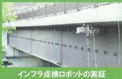
インフラ点検ロボットの実証
