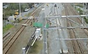
⑦ 長崎町(仮線切替箇所)
