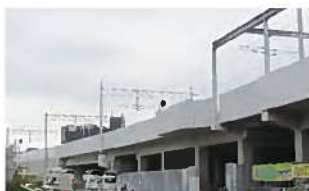
③ 堀川町(駅部周辺の高架)
