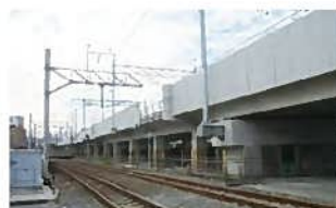
⑥ 北鷹見町(短絡線横の高架)
