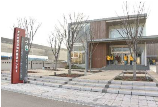
緊急物資輸送センター
