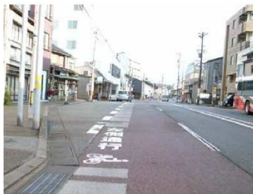
②バス専用通行帯を活用し路面表示 を設置した事例
