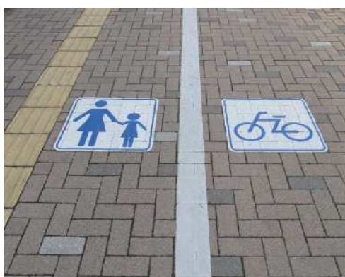
【通行区分路面表示】
