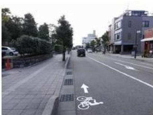
①ピクトグラムを設置した事例
