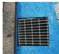
※側溝や雨水枿に設置しているグレーチング蓋について、格子の長辺が車両進行方向と重なっている場合は、格子の長辺が車両進行方向と直角になるタイプへ交換するなどの対策を行うこと。
