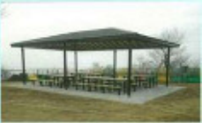
【帆柱自然公園の整備】
