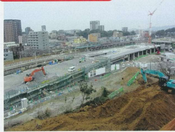
鹿児島本線の南側に、短絡線高架橋を整備(鹿児島本線2次仮線として使用)
