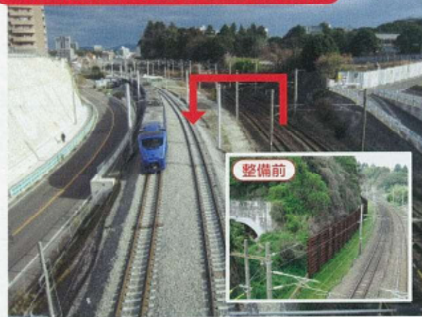
筑豊本線トンネル工事・短絡線高架工事のため、既存の鹿児島本線の北側の国道トンネルを撤去し1次仮線を敷設(平成24年12月)
