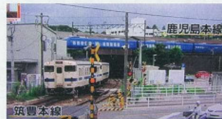
2つの鉄道が立体交差
