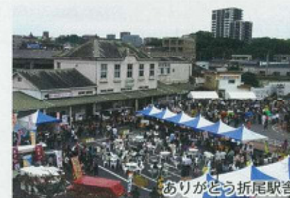
ありがとう折尾駅舎 折尾駅舎解体の感謝イベント(来場者3万人) (H24.10月)
