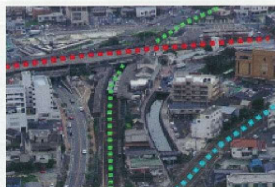
3つの鉄道が市街地を分断 (折尾駅の南側から北向きに見た写真)
