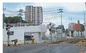
駅部・国道踏切周辺の高架工事
