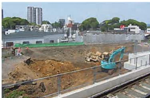
既設盛土の撤去等
