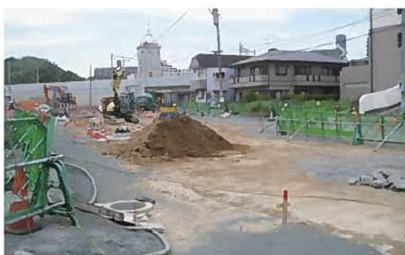
③ 折尾堀川町線の道路改築工事〔堀川町〕
