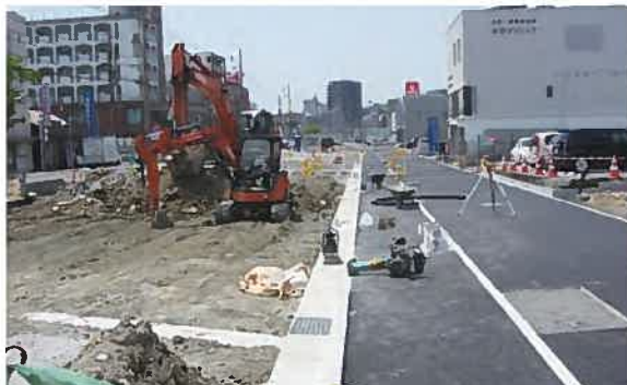
① 日吉台光明線の拡幅工事〔折尾一丁目〕
