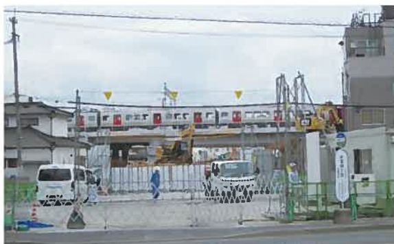
② 折尾堀川町線の道路改築工事〔折尾四丁目〕
