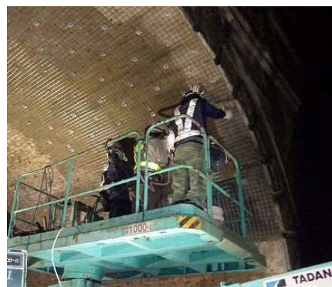
補修工事の例(剥落防止工)
