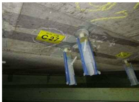
リニューアル工事の例（ひびわれ注入工）
