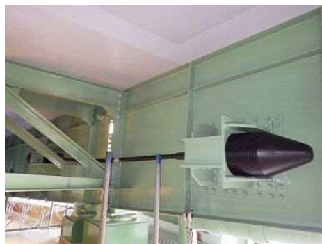
耐震対策工事の例（落橋防止装置）
