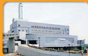
② 日明工場 1日に600tのごみ処理が可能です。 発電出力は6,000kWです。 ☎093-581-7976
