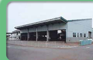
⑧ 日明かんびん資源化センター ごみの再資源化のための施設。収集した、かん・びん・ペットボトル・紙パック・トレイを分別します。 ☎093-583-7200
