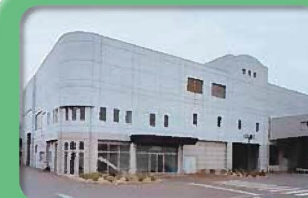
⑥ 日明粗大ごみ資源化センター 1日に200tの粗大ごみを受け入れることができます。処理能力:せん断50t/5h +回転150t/5h ☎093-581-7976
