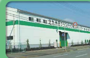
⑦ プラスチック資源化センター ごみの再資源化のための施設。収集したプラスチック製容器包装を分別します。 ☎093-591-5346
