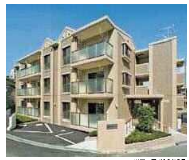
竣工 平成19年8月
