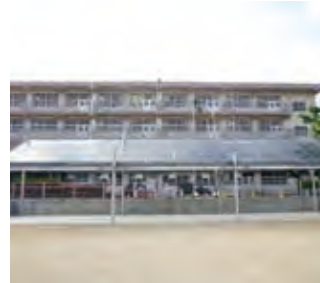
太陽光発電設備（出力10kWの設置例）
