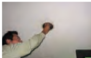
白熱電球のLED照明への更新
