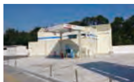
八幡東田水素ステーション (JXTGエネルギー株)
