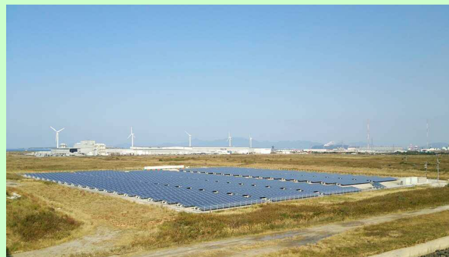
北九州市民太陽光発電所
