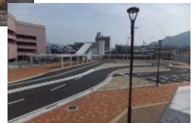
写真 城野駅南口駅前広場の整備
