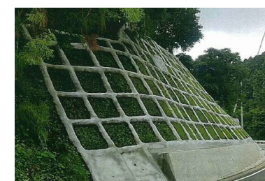
簡易吹付法枠
