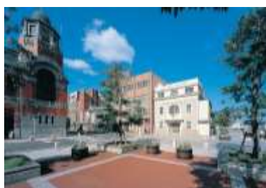
ホーム・リングガ商会（門司港レトロ地区界隈） （門司区）
