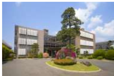
建築物部門 安川電機本社 (八幡西区)
