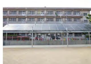
太陽光発電設備 (出力10kWの設置例)
