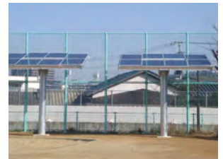
太陽光発電設備 (出力3kWの設置例)
