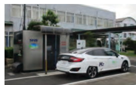
スマート水素ステーション
