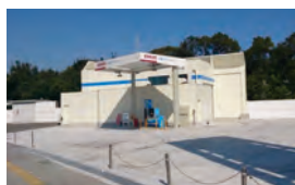
八幡東田水素ステーション (JXTGエネルギー株)
