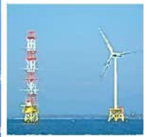
電源開発株式会社 2.0MW
