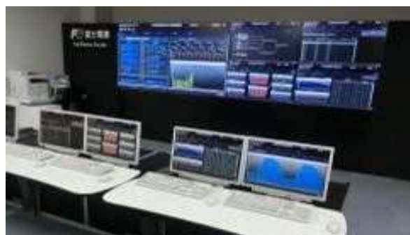
写真 地域節電所
