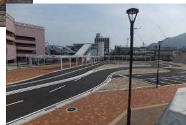
写真 城野駅南口駅前広場の整備
