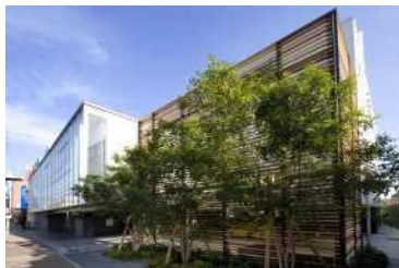
建築物部門 福岡銀行 折尾支店 (八幡西区)
