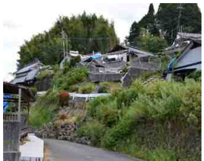
〔宅地・住宅の被災状況〕
