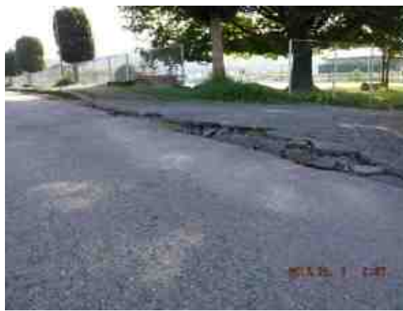
亀裂の入った舗装
