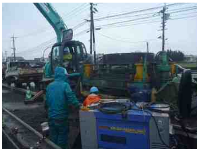
【下水道災害復旧工事中】
