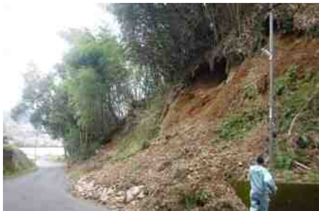
法面が崩落した道
