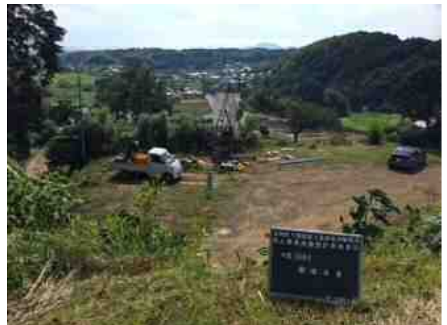
〔ボーリング調査状況(住宅解体後の更地)〕
