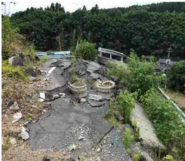
〔宅地に接する道路の被災状況〕
