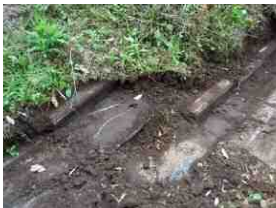
ずれた L 型側溝
