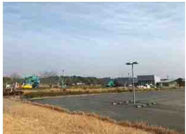
益城町総合運動公園体育館 解体中
