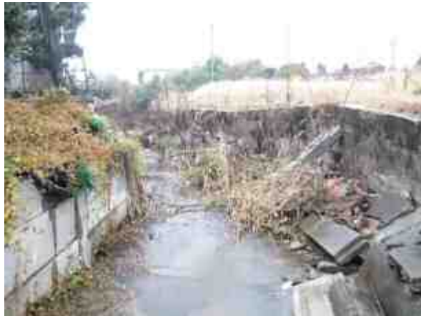
護岸が崩壊した河川
