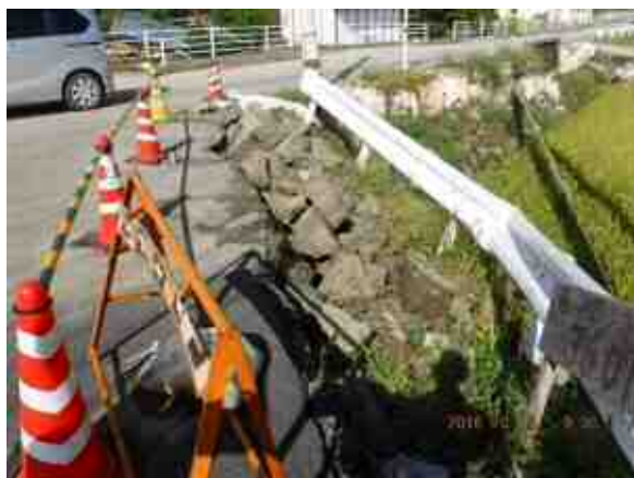
崩壊した路肩の石積み
