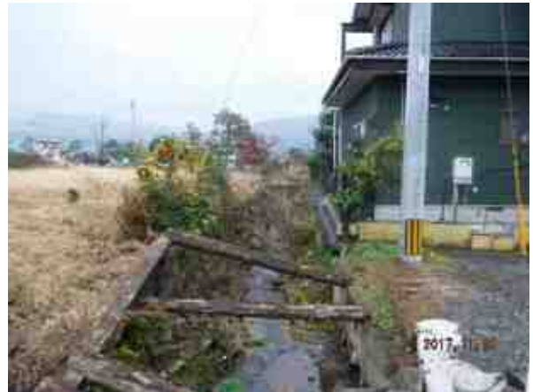
護岸が崩壊した河川
