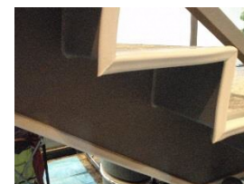
ホワイエ階段側面・ 下面へのカバー取り付け
