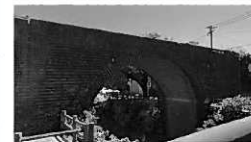
「茶屋町橋梁の存在感」 佐々木 真紀 普段の生活にも旧電車道を実感する圧倒的な存在感です。
