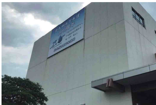
PR看板設置 (楠橋ポンプ場)
