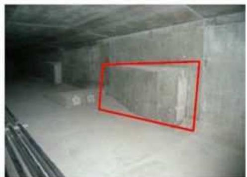
※本事例では、箱桁内の縦締めであるため、90番台とし、ウェブは91番とする。縦締めウェブの下2桁は、起点側からの定着突起の箇所数とする。このとき、両桁端部は箱桁内の定着突起状況を確認して要素番号を付けるか決定する。本事例では、端部に定着があると判断している。
