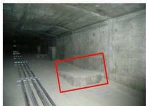
※本事例では、箱桁内の縦締めであるため、90番台とし、下床版は92番とする。縦締め下床版の下2桁は、起点側からの定着突起の箇所数とする。このとき、両桁端部は箱桁内の定着突起状況を確認して要素番号を付けるか決定する。本事例では、端部に定着があると判断している。
