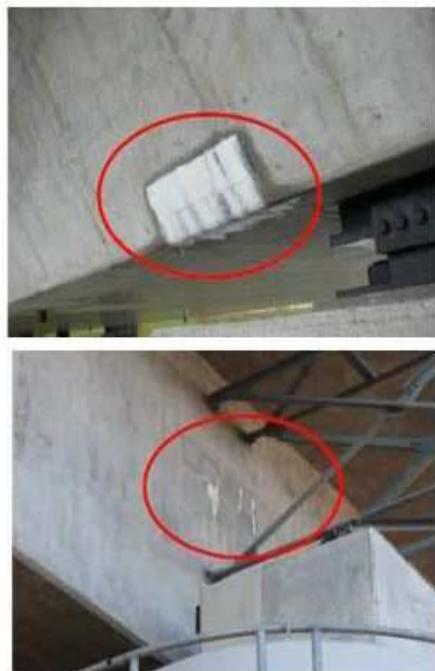
※地覆水切りが上床版までの打ち下ろしのため、横桁位置が確認できる。本事例では、縦縫めは01番とし、横桁横縫めが11番から始める。また、横桁横縫めの下2桁は、横桁の部材番号と同じとする。第1径間：1101, 1201, 1103, 1203 第2径間・第3径間：1102, 1202
