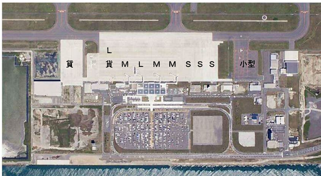
空港基本施設
