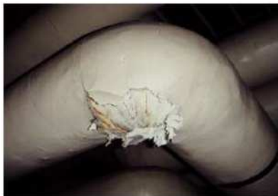
配管エルボの保温材
