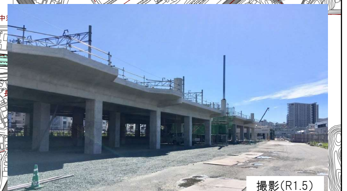
③ 鹿児島本線高架工事 (北鷹見町高架工区)
