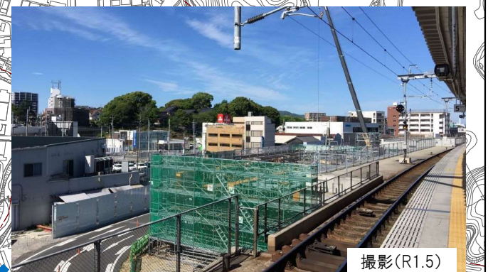
④ 鹿児島本線高架工事 (駅部高架工区)
