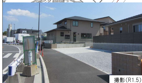
⑦ 宅地整備工事（堀川町地区）
