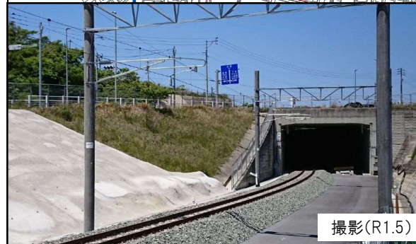
① トンネル終点部(国道3号付近)
