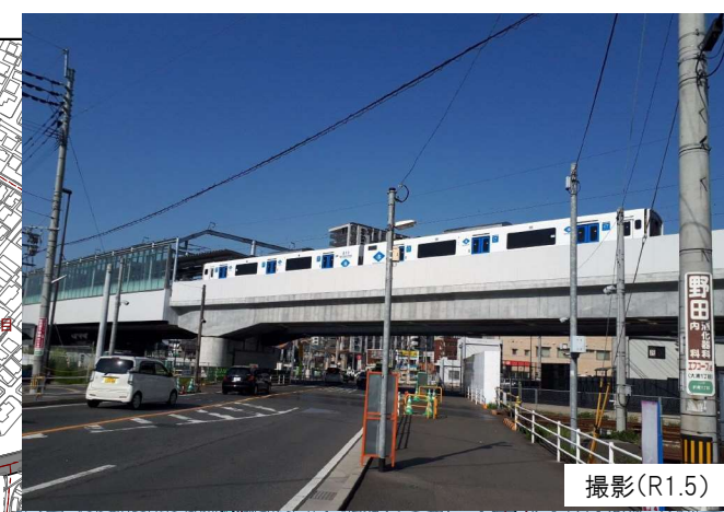
② 筑豊本線高架工事（国道踏切）
