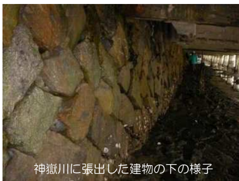
護岸の老朽化
