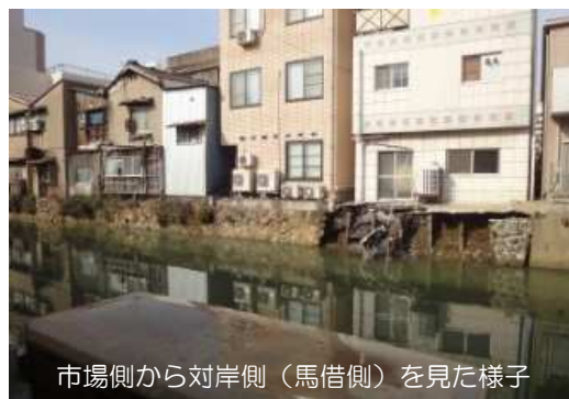
護岸の崩落（平成 26 年 3 月）
