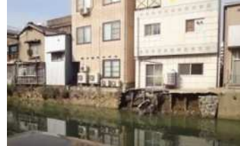
市場対岸側の護岸の崩落 (H26年3月)
