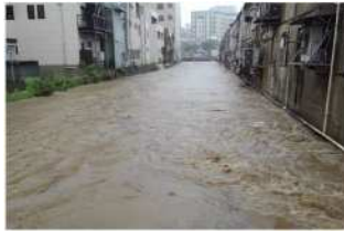
H30年の増水状況 (天神島橋下流)
