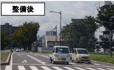
▲無電柱化事業(小倉北区)
