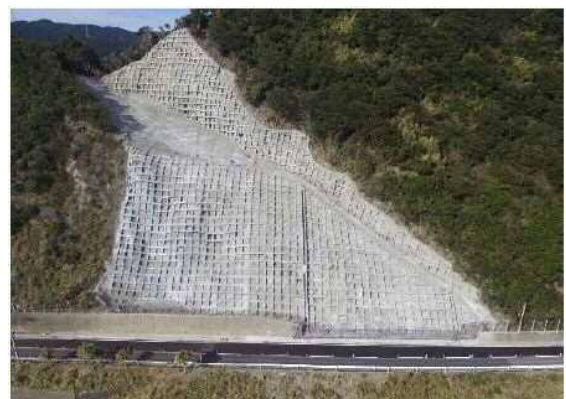
▲道路のり面の強化（対策イメージ）
