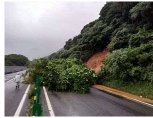
▲ H30.7豪雨災害 (北九州都市高速道路)
