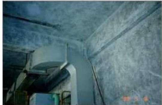
機械室の壁・天井の断熱
