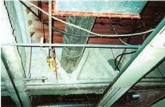
鉄骨造の梁・柱の耐火被覆
