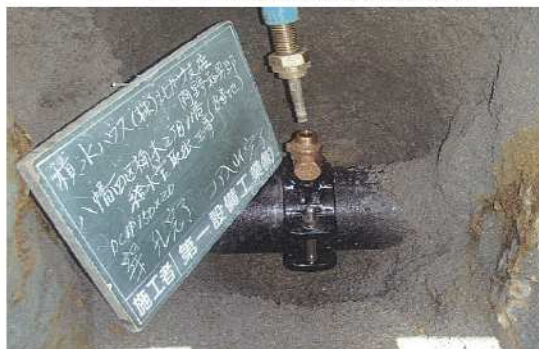
③ サドル付分水栓（割T字）取付状況写真
