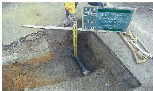
① 既設配水管埋設状況写真
