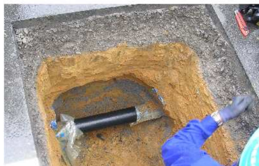
② 既設配水管外観状況写真
