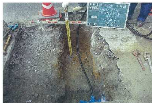
④ 給水管布設状況写真
