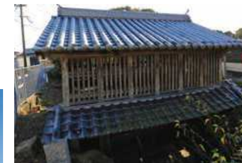
8 寿命の唐戸 (水門) 所在地/八幡西区楠橋西 3-12 竣工/1804年 設計/不詳
