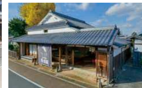
9 立場茶屋銀杏屋 所在地/八幡西区石坂 1-4-6 竣工/1837年 設計/不詳
