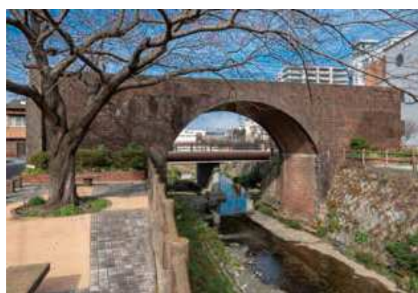
5 九州鉄道茶屋町橋梁 所在地/八幡東区茶屋町 4 竣工/1891年 設計/不詳
