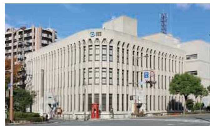
16 門司電気通信レトロ館（旧門司郵便局電話課） 所在地／門司区浜町 4-1 竣工／1924年 設計／山田守（逓信省）
