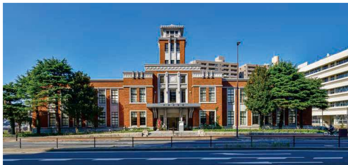
39 北九州市立戸畑図書館 (旧戸畑市役所) 所在地/戸畑区新池 1-1-1 改修/2014年 設計/榑青木茂建築工房 所在地/同上 竣工/1933年 設計/福岡県営繕課
