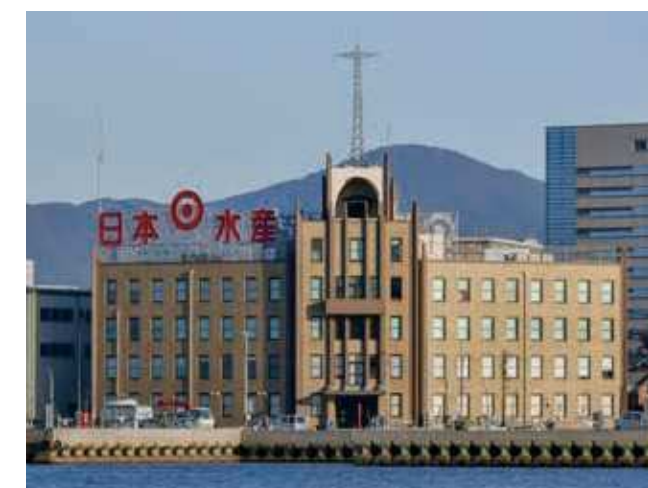
43 ニッセイ戸畑ビル (旧共同漁業ビル) 所在地/戸畑区銀座 2-6-27 竣工/1936年 設計/榑竹中工務店
