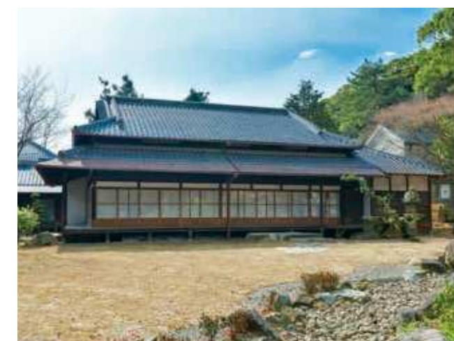
40 旧安川邸 大座敷 所在地/戸畑区一枝 1-4-23 竣工/1912年(移築) 設計/不詳
