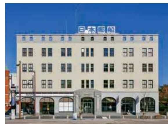
17 門司郵船ビル（旧日本郵船門司支店） 所在地／門司区港町 7-8 竣工／1927年 設計／八島知
