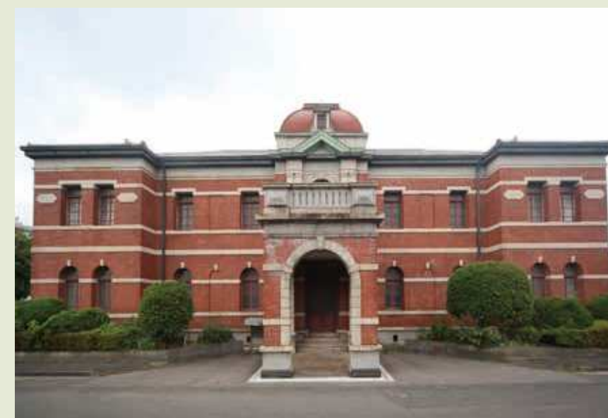
旧日本事務所
