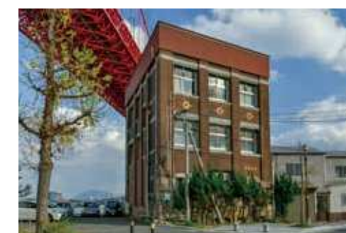
32 とちき 枋木ビル 所在地/若松区本町 1-15-10 竣工/1920年 設計/松田昌平
