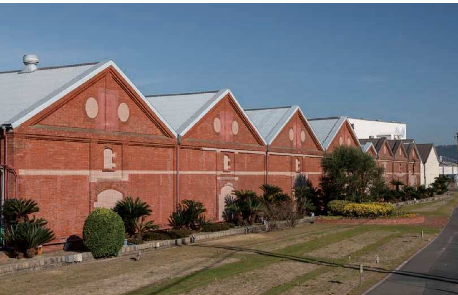
26 ニッカウヰスキー(株)門司工場 倉庫(旧大里製粉所倉庫) 所在地/門司区大里元町 2-1 竣工/1916年 設計/不詳 ※一般見学は行っていません
