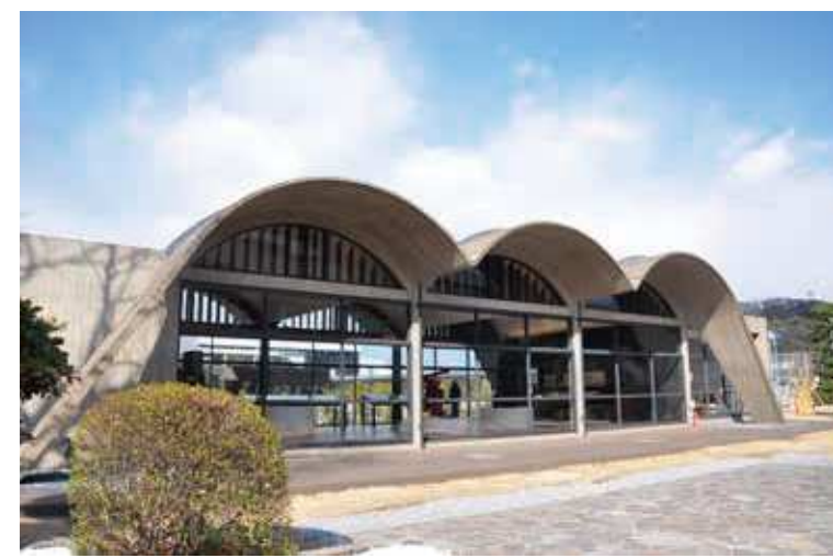
53 安川電機歴史館(安川電機旧本社事務所講堂) 所在地/八幡西区黒崎城石 2-1 竣工/1954年 設計/アントニン・レーモンド ※写真提供: 株式会社安川電機
