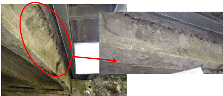
▲ 橋梁のひび割れ状況
