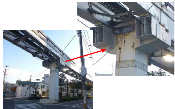
▲ モノレール・鋼製支柱の劣化状況
