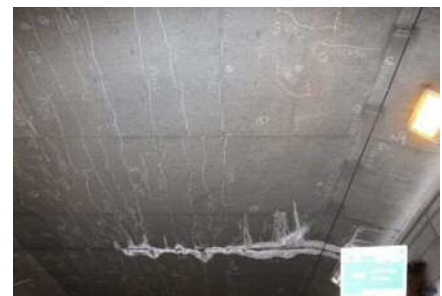
▲ トンネルのひび割れ状況
