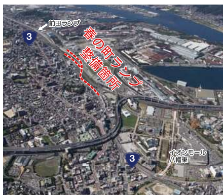
▲国道3号黒崎バイパス (春の町ランプ整備箇所)
