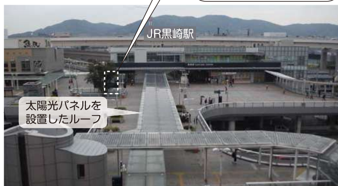
▲太陽光パネルの設置 (JR黒崎駅ペDESTリアンデッキのルーフ)
