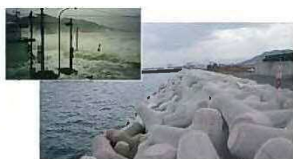
新門司地区における護岸整備状況
