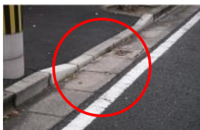
【正しい施工事例】
